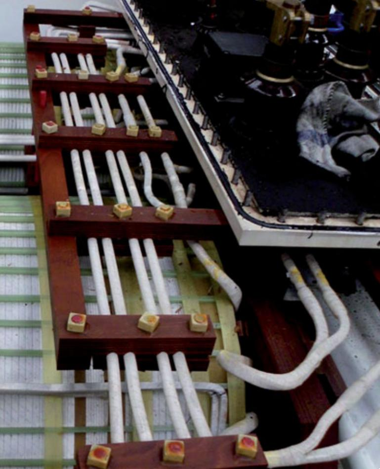
Häufig kann das Aktivteil „nachgespannt“ werden, was deutlich günstiger ist als eine Neuwicklung des Spulenpakets. Durch eine regelmäßige FRA-Messung im Abstand von fünf bis sieben Jahren kann der Transformator über seine gesamte Lebensdauer beurteilt werden.
